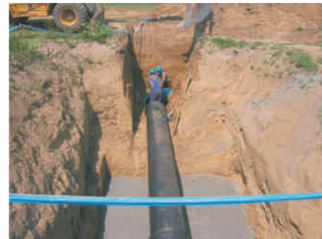
Instalare conductă de aducțiune
