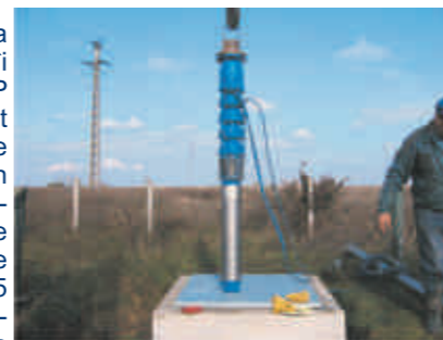
Montarea unei pompe submersibile la un puț de captare a apei
