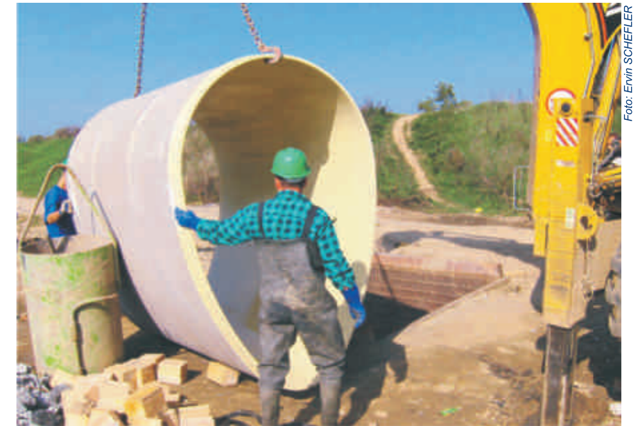
Sistemul de canalizare: Instalare conductă de canalizare cu secțiune ovoidă din fibră de sticlă pe canalul colector din Micro 16
