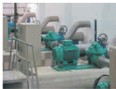
Stația de la Mărtinești: Pompe noi instalate în stația de pompare
