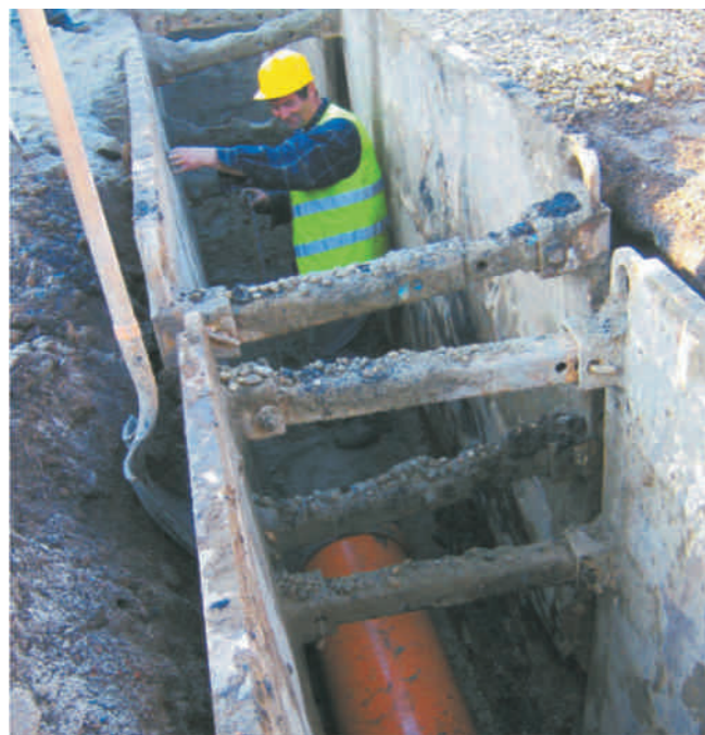
Sistemul de canalizare: Lucrări de reabilitare a conductei de canalizare pe Strada Păulești
