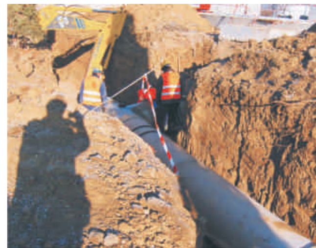
Stația de epurare: instalare conductă de apă decantată
