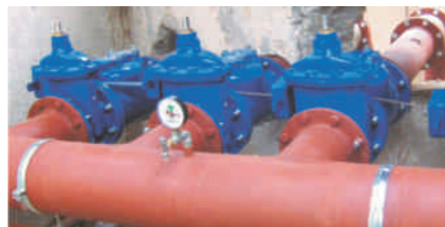
Sistemul de canalizare: Vane noi la stația de pompare a apelor uzate din cartierul Carpați II
