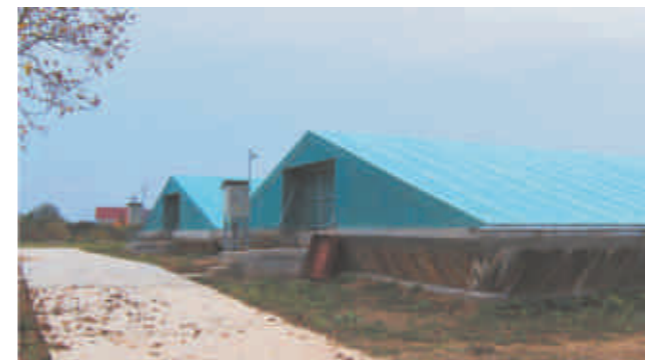
Stația de la Mărtinești: Decantoarele reabilite pentru apa de spălare a filtrelor
