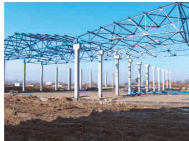
Stația de epurare: construirea depozitului temporar pentru nămolul tratat
